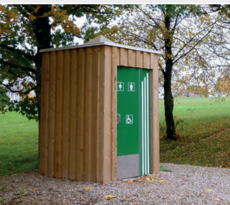
Деревянная обшивка внахлёт (1 на 2) досками, импрегнированными под давлением
