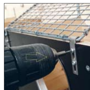
4: Fastgør krogene med en el-skruestrækker.
